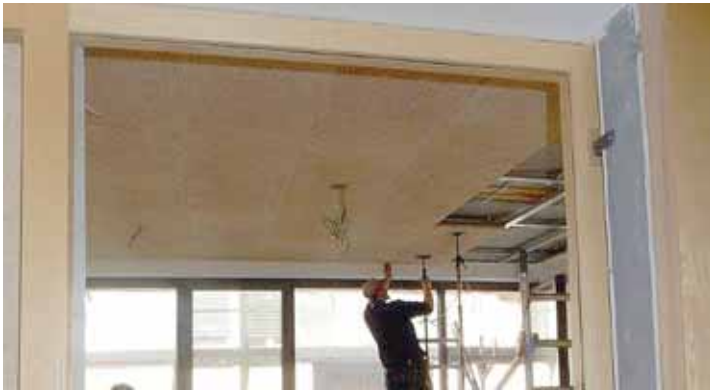
Im Umbaubereich werden aktuell die Akustikdecken und die Beleuchtung montiert.
