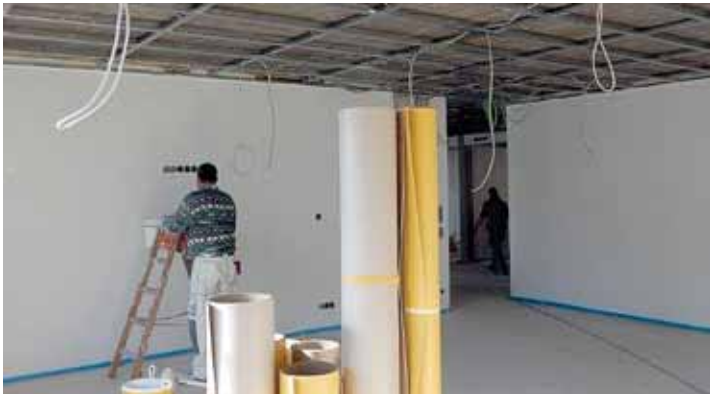
Im Neubaubereich werden aktuell die Wände gestrichen. Auch hier werden im Anschluss die Akustikdecke sowie die Beleuchtung montiert.
