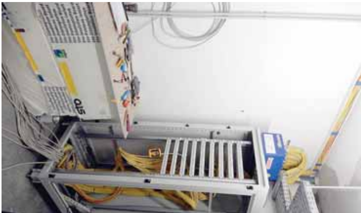
Die Verkabelung wurde mittlerweile entsprechend aufgelegt und auch die Lüftungsanlage für die innenliegenden Räume ist installiert. Der Bezug des Neubaus ist für das neue Schuljahr 2019/2020 geplant.
