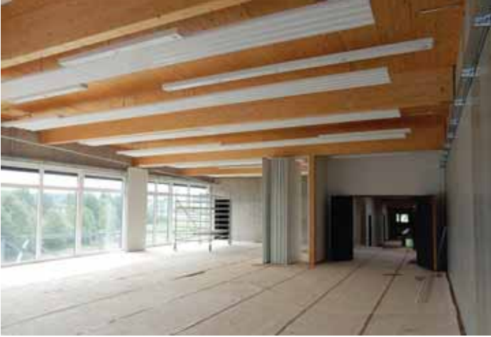
Zukünftiger Schulungsraum der Feuerwehr mit Trennwand.
