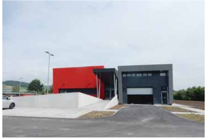
Zufahrt und Eingang zum Bereich des DRK sowie der Eingang zum Feuerwehrgerätehaus.
