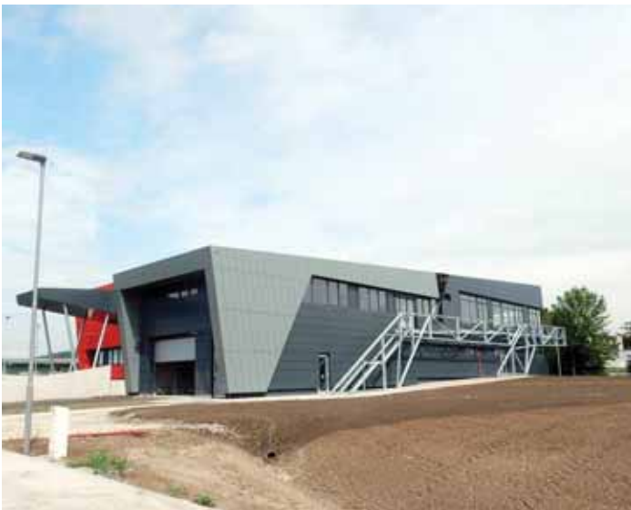
Blick auf die Gebäudeostseite. Auch im Inneren des Gebäudes wird auf die Fertigstellung hingearbeitet. In den nächsten Wochen werden die Schutzfolien auf den Böden entfernt, alle Räume gereinigt und die noch notwendigen Einbauten durchgeführt.
