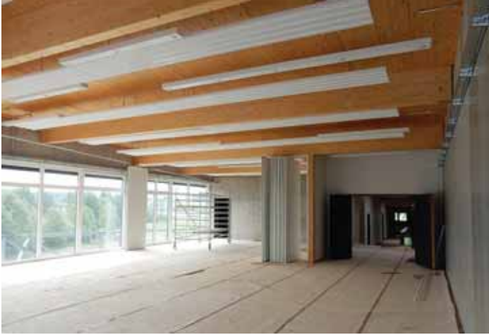
Zukünftiger Schulungsraum der Feuerwehr mit Trennwand.
