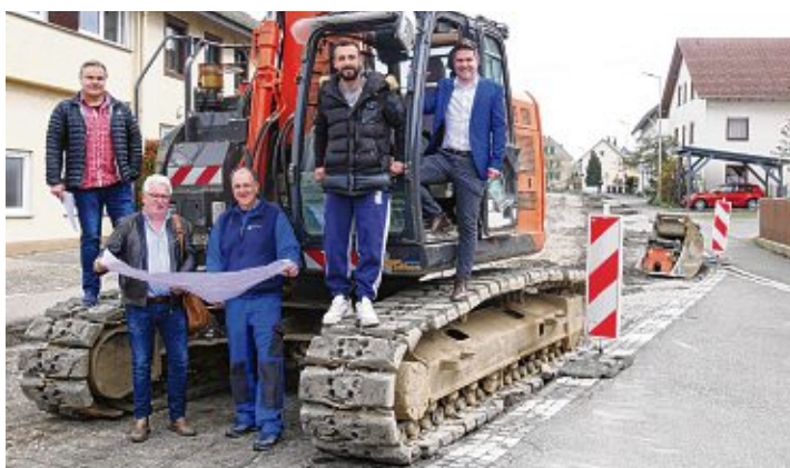
Günther Feucht (Bauamtsleiter), Burkhard Raff (Planer), Markus Unger (Firma Walter Unger Rohrleitungsbau GmbH, Frickingen), Michael Lopes (Firma Lopes Tiefbau, Singen), Bürgermeister Holger Mayer (von links) auf der Baustelle in der Hauptstraße von der Sonne bis zur Randenbahnstraße. Bild: Gemeinde Hilzingen
