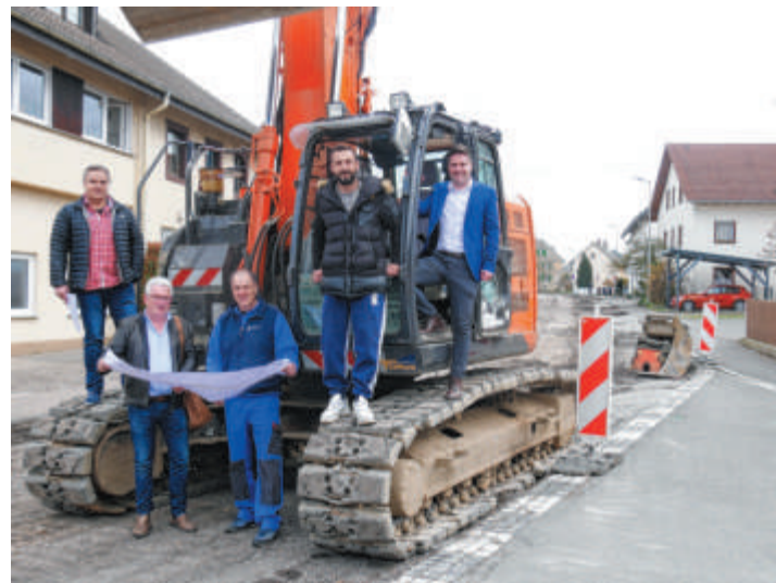
Von links: Günther Feucht (Bauamtsleiter), Burkhard Raff (Planer), Markus Unger (Firma Walter Unger Rohrleitungsbau GmbH, Frickingen), Michael Lopes (Firma Lopes Tiefbau, Singen) und Bürgermeister Holger Mayer beim Start der Baustelle in der Hauptstraße von der Sonne bis zur Randenbahnstraße.
