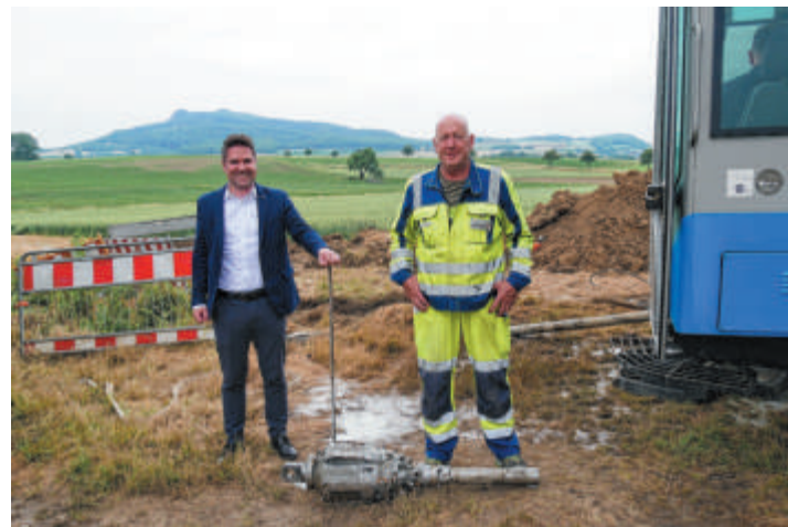
Bürgermeister Holger Mayer hat sich vor Ort durch Wassermeister Ersig über den Stand der Baumaßnahme zur Wasserversorgung in Schlatt am Randen informiert.
