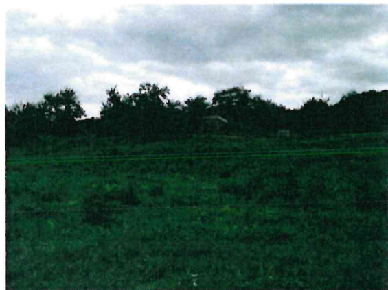
Wasserhochbehälter nördl. Plangebiet
