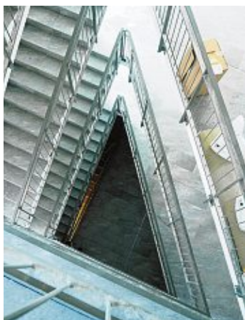
Blick ins Treppenhaus: Das Gebäude verfügt auch über einen Aufzug.
