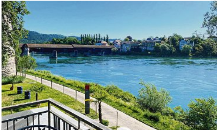
Malerisch sieht die Brücke in Bad-Säckingen aus.
