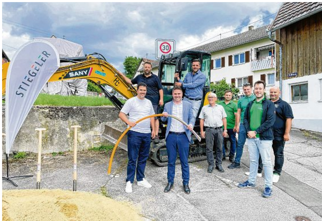
Ortsvorsteher Nico Merkt und Bürgermeister Holger Mayer freuen sich mit Vertretern der Gemeinde darüber, dass es nun mit dem Ausbau des Glasfasernetz in Binningen losgeht. Bild: Gemeindeverwaltung
