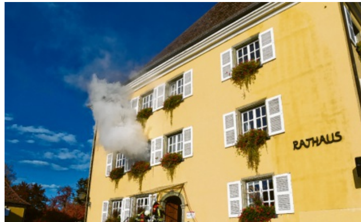
Dichter Rauch drang aus einem Fenster im ersten Obergeschoss des Rathauses - die Feuerwehr rückte mit Atemschutzgeräten an.
