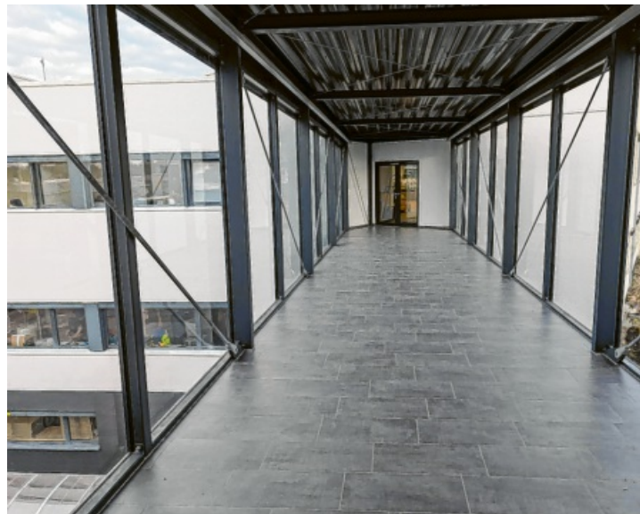
Über einen Verbindungsgang ist der Neubau mit den Bestandsgebäuden verbunden, die ebenfalls saniert wurden. Foto: Graf
