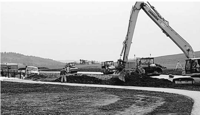
Der neue Radweg ist bereits an das Brückenbauwerk über den Mühlenbach angeschlossen. Die Mutterbodenarbeiten im Radwegbereich sind weitestgehend abgeschlossen. Die bituminöse Tragschicht der L 190 ist kurz vor der Fertigstellung.
