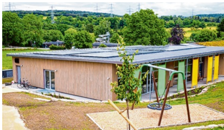
Der Neubau: Auch der Außenraum lädt zum Toben und Bewegen ein.
