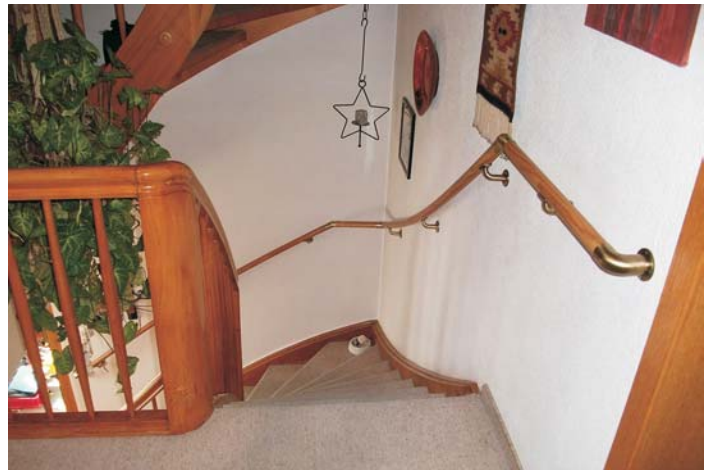
Ein wandseitiger Handlauf, dort wo die Stufen breiter sind, gibt mehr Sicherheit.
