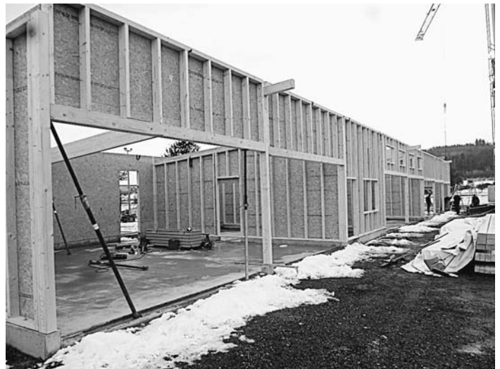
Eindrucksvoll zeigt sich der 45 Meter lange Rohbau des Wirtschaftsgebäudes auf dem Festplatz in Hilzingen. Direkt an diese Längsseite wird sich künftig das Kirchweih-Festzelt anschließen.
