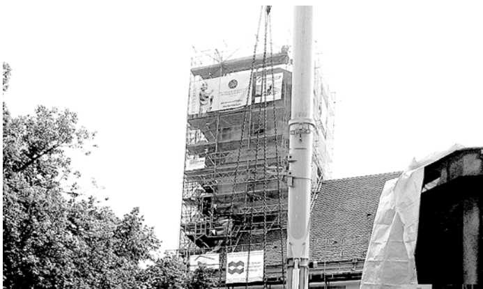
Der Glockenstuhl kurz vor der Installation im Turm.
