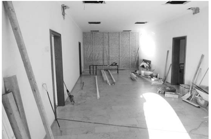
Erstellung der Staubschutzwand sowie Demontage Flurbeleuchtung.
