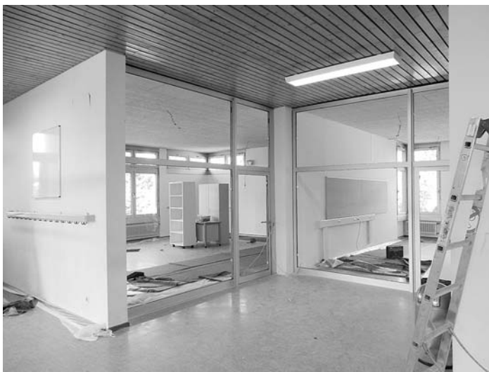
Die alten Trennwände werden ersetzt, und die neuen Glastrennwände montiert.
