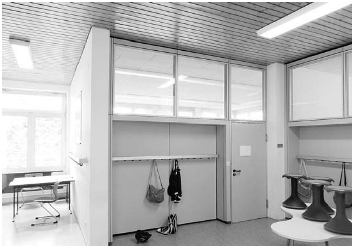
Die alten Trennwände in der Schule Hilzingen.
