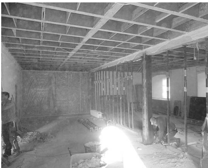
Wände des Einwohnermeldeamtes sowie die Wände des Maschinenraumes sind bereits entfernt. Die bestehenden Stahlträger unter der Decke werden bis zur Beendigung der Sicherungsmaßnahmen noch von Stahlstützen (Stahlprießen) unterstützt.
