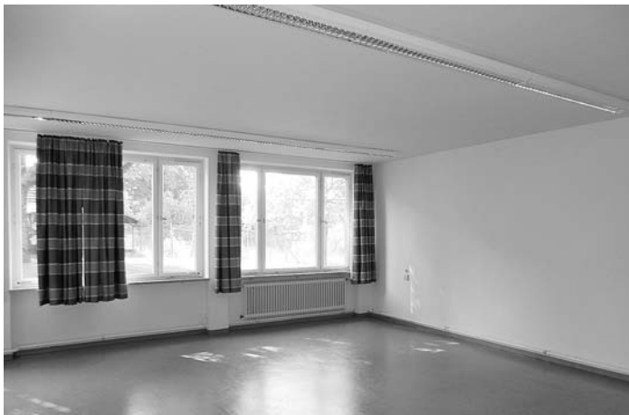
Neuer Klassenraum im Kellergeschoss der Grundschule Duchtlingen.
