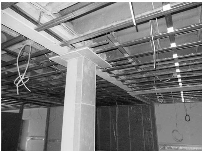
Die notwendigen Arbeiten zur Herstellung der Unterkonstruktion für die abgehängte Decke sowie die Elektroleitungen im Bereich der Decke sind beendet. Am Mittwoch, 1. Dezember, wurde mit der Montage der Schallschutzdecke begonnen, nachdem der Deckenrand bereits fertiggestellt wurde.
