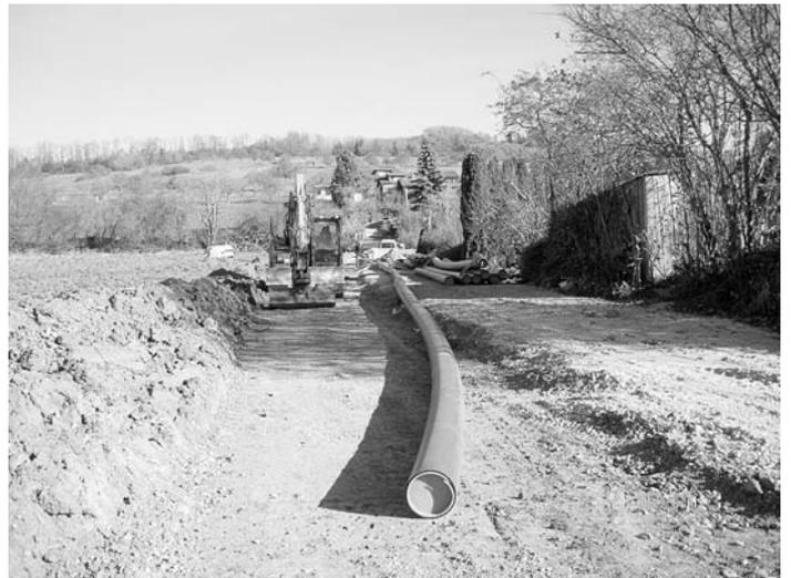
Mit einem neuen Kanal, der hinter der vorhandenen Bebauung in einem unbefestigten Feldweg verlegt wurde, kann somit dieses Wasser wieder ordnungsgemäß abgeleitet werden. Durch diese Vorgehensweise konnte der Straßenbelag in der Schwarzwaldstraße verschont und die Baukosten dadurch erheblich reduziert werden.
