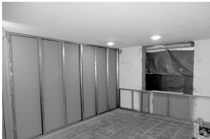
Der neue Durchbruch in die Halle sowie neue Ständerwand im Bereich des bisherigen Foyers.
