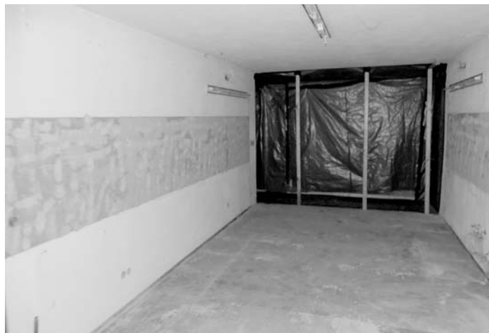
Die vorhandene Küche sowie das Tor Richtung Halle wurden bereits abgebaut und entsorgt.
