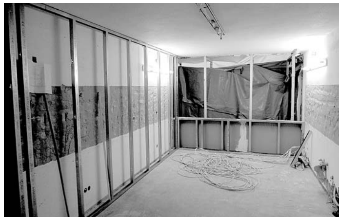
Die Metallständerwände im Bereich der alten Küche werden montiert. Des Weiteren beginnt bereits die Verlegung der Elektrokabel.
