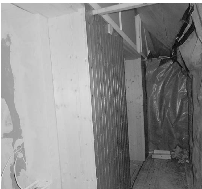
Die Wandverschalung im Bereich der Halle wurde bereits ergänzt und montiert.
