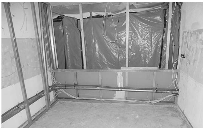
Elektro-, Wasser- und Abwasserinstallationen in den neuen Leichtbautrennwänden.
