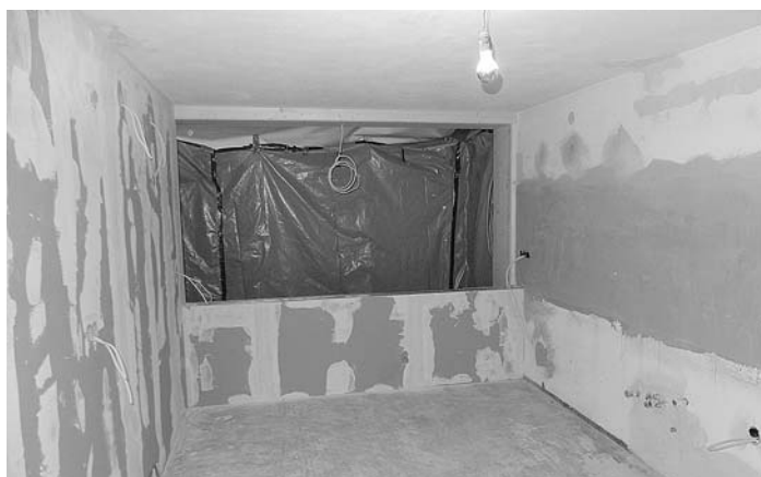
Die Leichtbautrennwände wurden geschlossen und verspachtelt.
