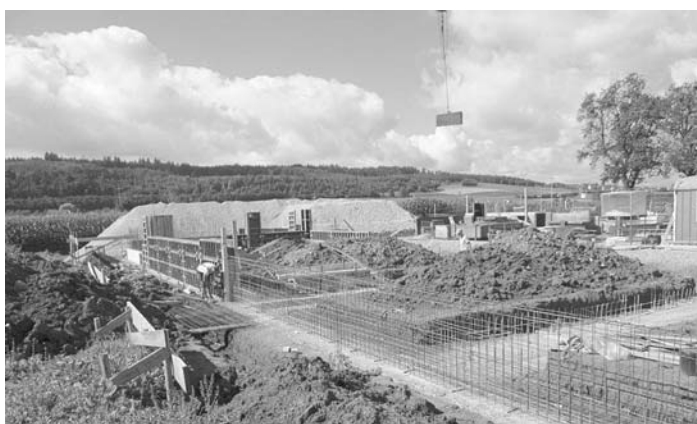
Das Fundament stand Ende Mai.
