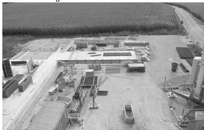
Bis Ende Oktober war der Erdgeschossfußboden fertiggestellt, und bis Ende November standen alle Erdgeschosswände.
