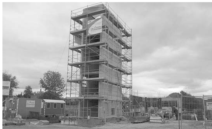
Bereits Mitte August war der Schlauchturm erstellt.
