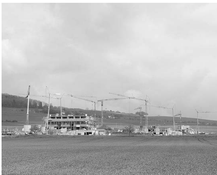
Im Hilzinger Baugebiet »Beim Steppbachwiesle« kann zur Zeit eine rege Bautätigkeit beobachtet werden.
