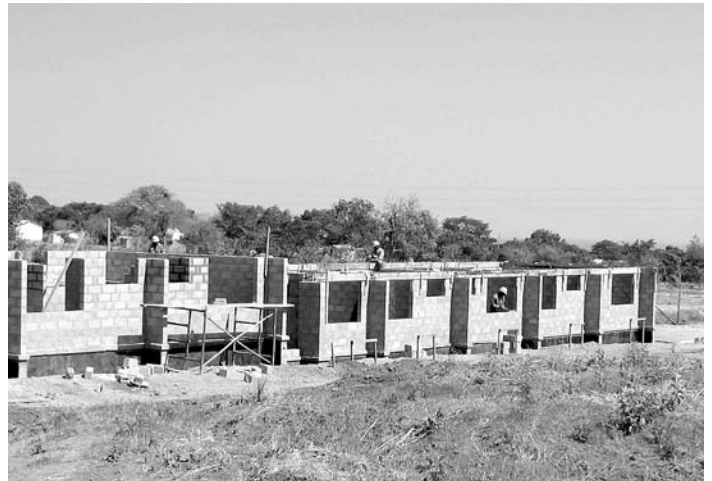
Das Foto zeigt die ersten Maurerarbeiten: Die Hebammenschule von Chilonga entsteht wieder. Laut der Hilfsorganisation »Brücke der Freundschaft«, Ebringen, soll sie im Sommer 2018 wieder Schülerinnen ausbilden.
