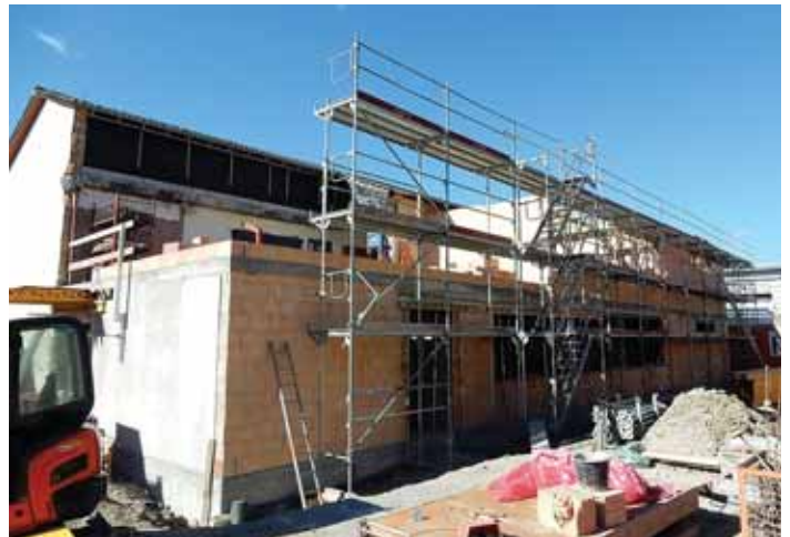
Ansicht von Norden: Hier entstehen die neuen Inputräume sowie die WC-Anlage und Treppenlage mit Aufzug.
