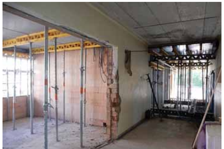
Blick ins Innere der Baustelle: Bestehender Flur (Altbau Südbau) mit Blick Richtung Osten (hier entsteht der Neubau/Erweiterungsbau) sowie bereits realisierter Anbau auf der Gebäudenordseite.
