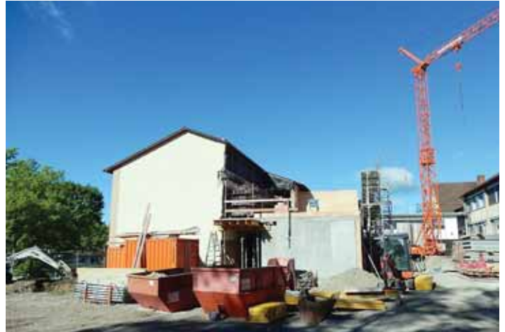
Ansicht von Osten: Der Anbau parallel zum Altbau (Südbau) ist im Erdgeschoss bereits fertiggestellt. Im Obergeschoss wurde mit den Maurerarbeiten bereits begonnen.
