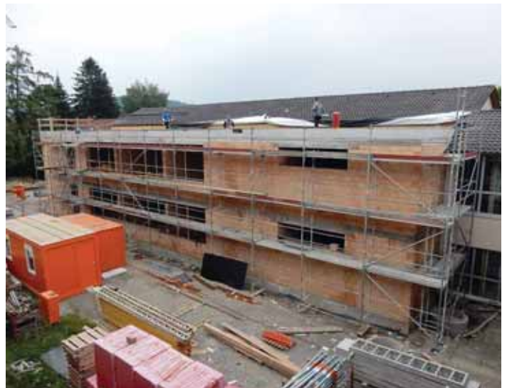
Für den neuen Kopfbau, welcher östlich an den bestehenden Südbau anschließt, werden aktuell die Fundamente betoniert.
