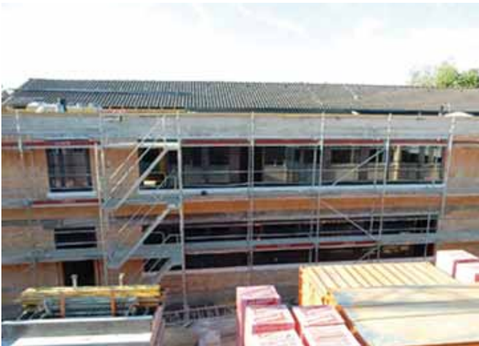
Die Fenster im Bereich des Südbaus (Richtung Norden/Innenhof) sind eingebaut.
