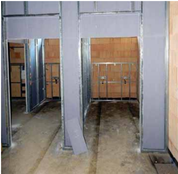
Aktuell werden die Trockenbauarbeiten sowie die Rohbauinstallationen für Elektro und Sanitär ausgeführt.
