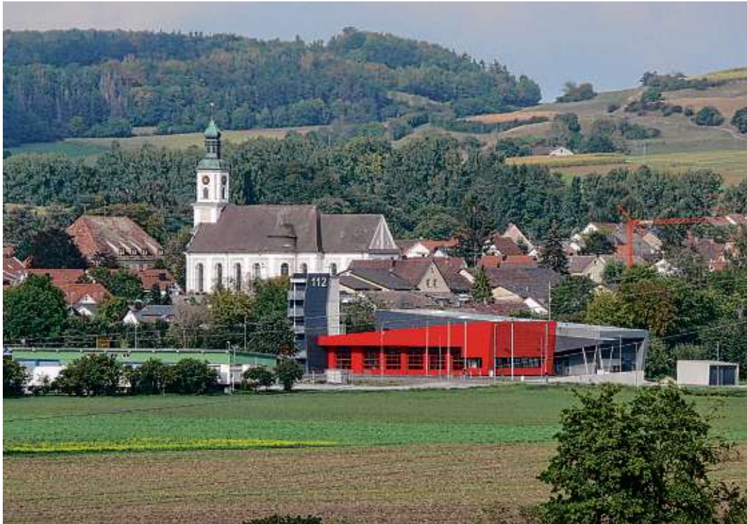
Das markante Gebäude fügt moderne, dynamische Aspekte zum Hilzinger Ortsbild hinzu.
