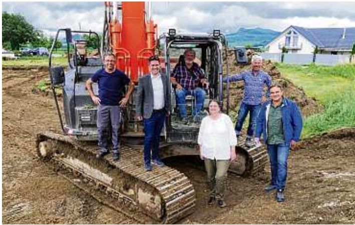
Spatenstich im Neubaugebiet Kirchhofacker in Schlatt am Randen.
