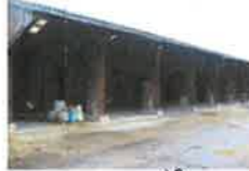
Die ehemalige Getreidehalle (6)
