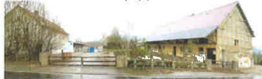
Eingangssituation von der Hauptstraße aus (1)
