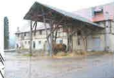
Der ehemalige "große" Stall mit Lagerräume (4)
